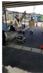
赤外線調査による非破壊検査技術
