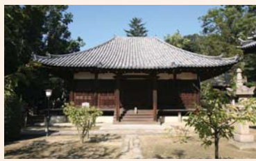
国指定重要文化財 本蓮寺 本堂
