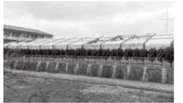
台風により破損した長船町B&Gプールの屋根
