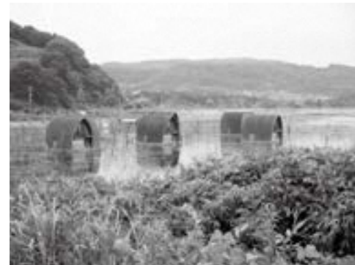
浸水している鹿忍塩田跡地
