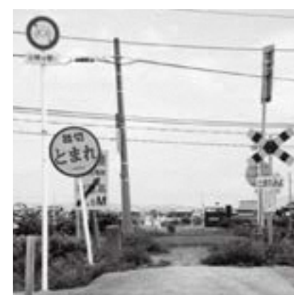
警報機のない踏切
