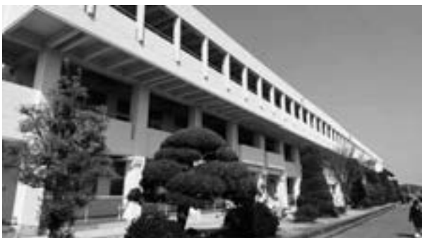
大規模改修を終えた邑久中学校南棟
