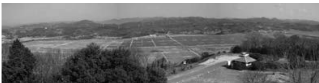
工事が進むメガソーラー（錦海塩田跡地）
