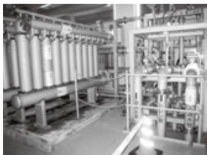
膜ろ過方式による浄水設備の例
