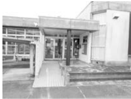
昭和51年建築の玉津コミュニティセンター
