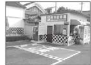
電気自動車急速充電スタンド（岡山県ホームページより）
