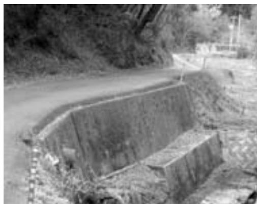
幅員の狭い生塚知尾間
