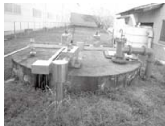
老朽化した長船水源地
