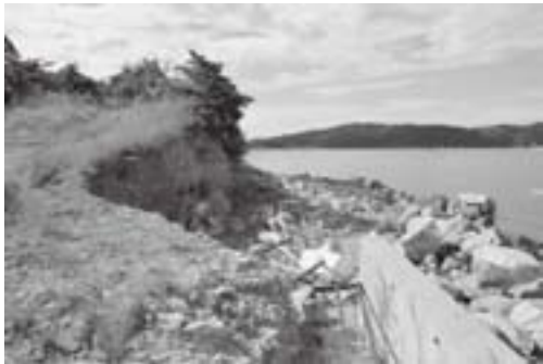
波の浸食により崩壊した前島キャンプ場
