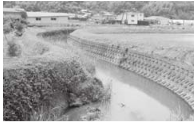
未整備の河川（大土井地区内）
