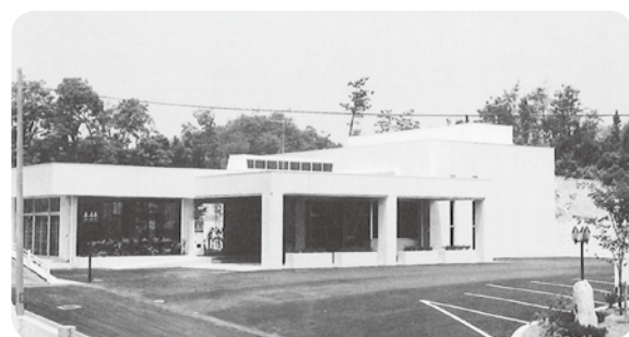
現地建て替えは困難との方針が出された西大寺斎場
