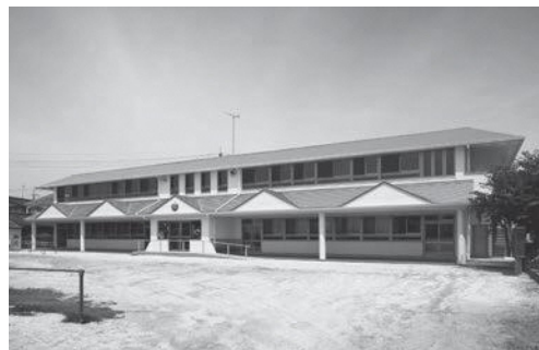
工事が完了した牛窓東幼稚園園舎
