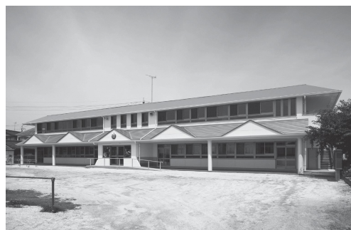
工事が完了した牛窓東幼稚園園舎
