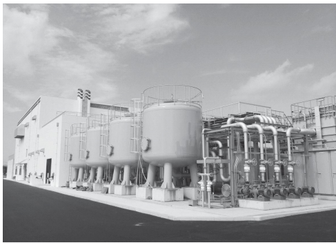
新福山浄水場
