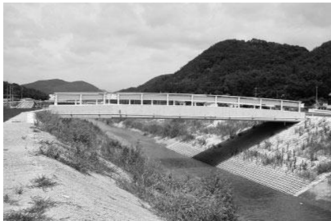
河川改修工事が完了した是安川
