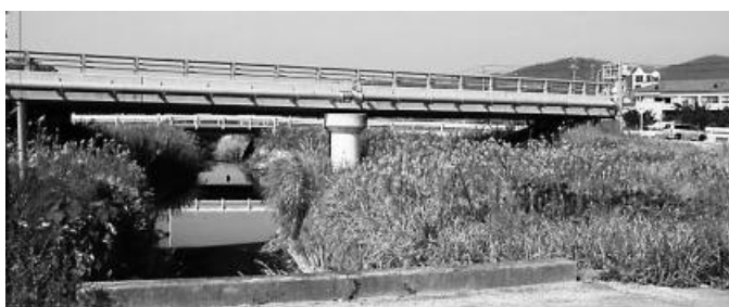
千町川河川改修工事箇所（邑久町本庄地内）
