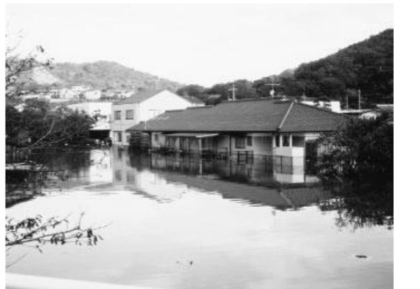
昨年の台風16号で浸水被害のあった牛窓町紺浦地区
