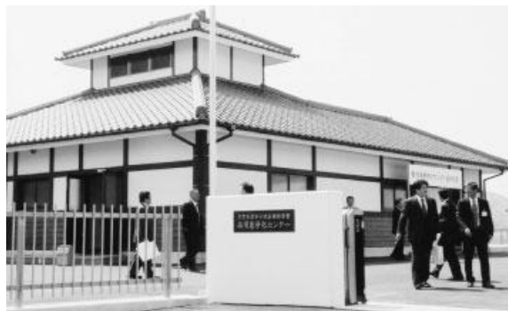
540人分の生活雑排水などを処理する、西須恵浄化センター
