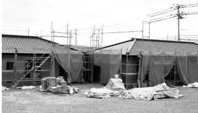
建て替えが行われている弁天市営住宅
