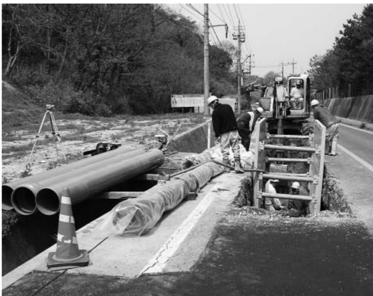
下水道工事が市内各所で行われています
