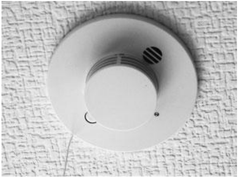
天井埋め込み式の火災警報機
