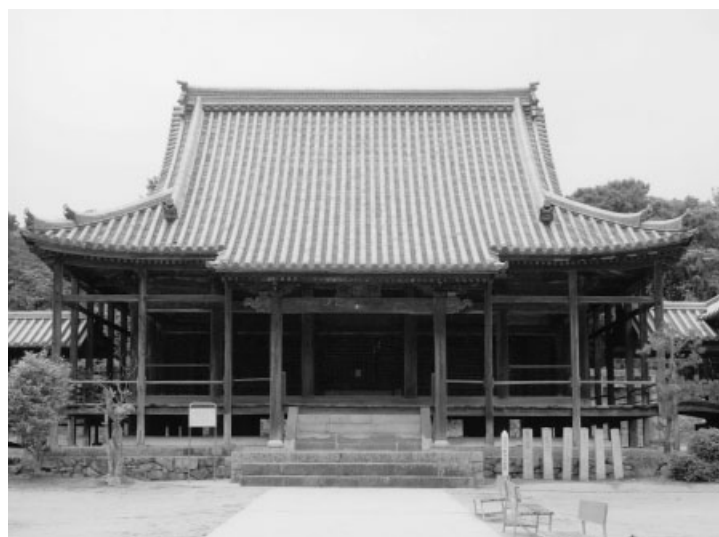
邑久大工の建築による静円寺本堂（邑久町本庄）
