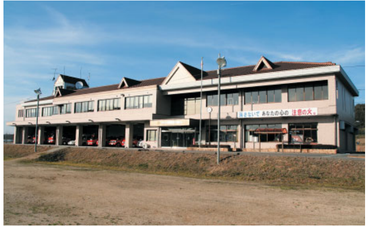
平成7年に完成した瀬戸内市消防本部・消防署
