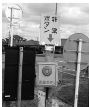
踏切内でトラブルが起こったら「非常ボタン」を押しましょう
