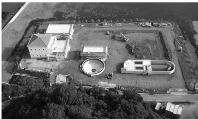
牛窓浄化センター
