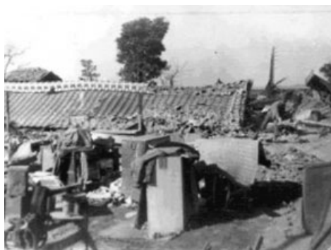
昭和南海地震での被害状況 写真提供:岡山地方気象台
