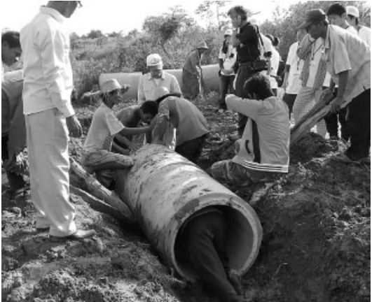
土が掘られヒューム管が埋められます
