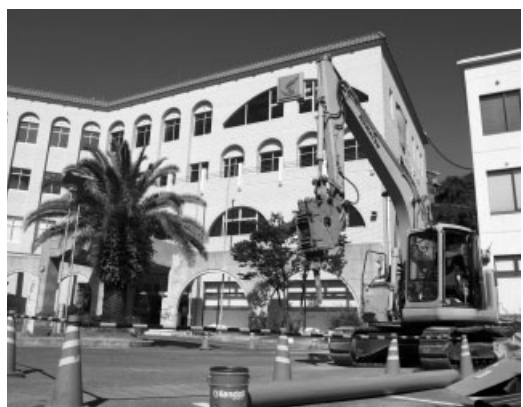
工事の進む牛窓支所庁舎
