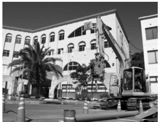
工事の進む牛窓支所庁舎
