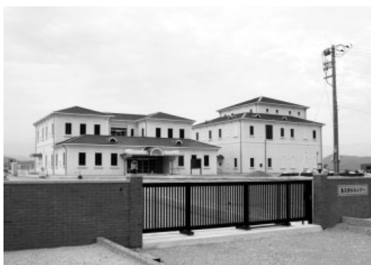
供用が開始された邑久浄化センター
