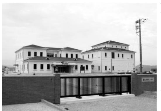
供用が開始された邑久浄化センター
