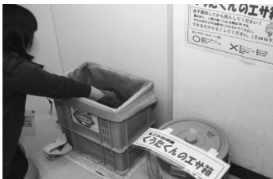
市役所給湯室に設置された生ゴミ処理装置「くうたくん」職員も愛情をもってまぜまぜ。分解を進めます。
