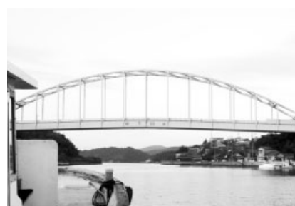
海から見る邑久長島大橋
