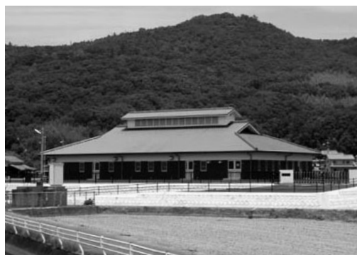
完成した美和・牛文浄化センター
