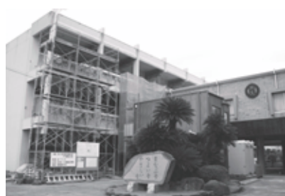
耐震工事が進む邑久小学校校舎
