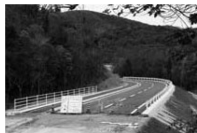
完成が近い市道南北線道路
