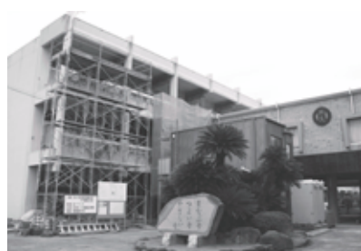
耐震工事が進む邑久小学校校舎
