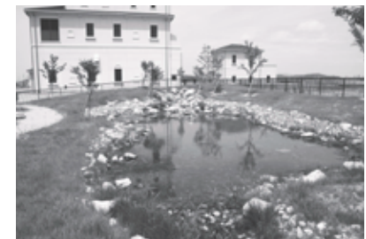
浄化した水を使った邑久処理センターのビオトープ
