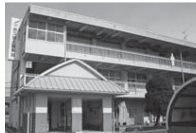
解体を検討している邑久郷土資料館
