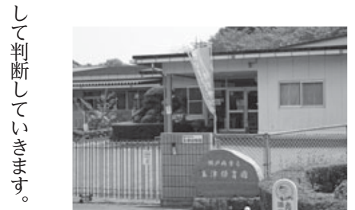
同じ敷地内にある玉津保育園と玉津幼稚園
