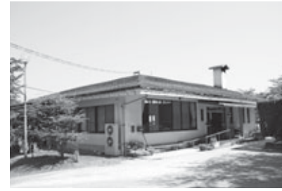
施設の老朽化が進む上寺山楽々園
