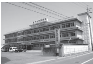
新病院建設の準備が進む瀬戸内市市民病院
