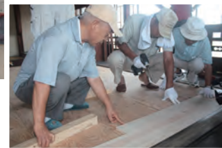
少しずつ進行する張り付け(左上) / 隙間ができないよう丁寧に作業を行う(右下)
