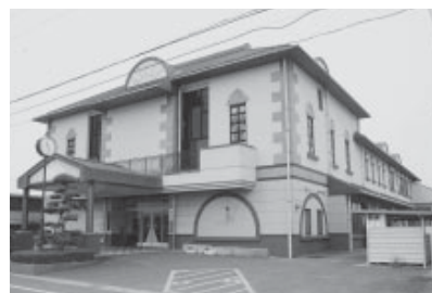
瀬戸内市総合福祉センター（旧邑久町総合福祉センター）
