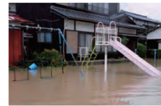
台風11号により被害を受けた牛窓町鹿忍地区の様子（左下/右上）
