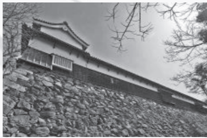
福岡城二ノ丸多聞櫓（提供：福岡市）
