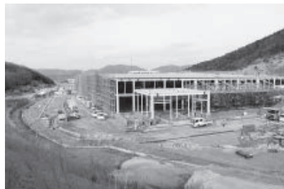
工場の建設が進む宮下工業団地
