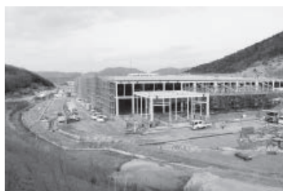
工場の建設が進む宮下工業団地
