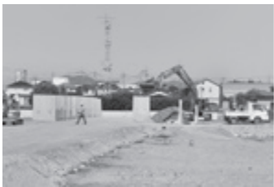
新病院建設予定地で進む造成工事
