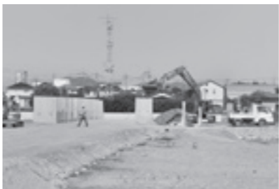
新病院建設予定地で進む造成工事
