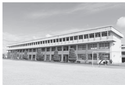
大規模改修予定の邑久中学校の校舎南棟
