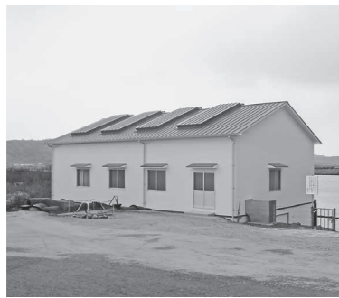
整備された排水ポンプ場
