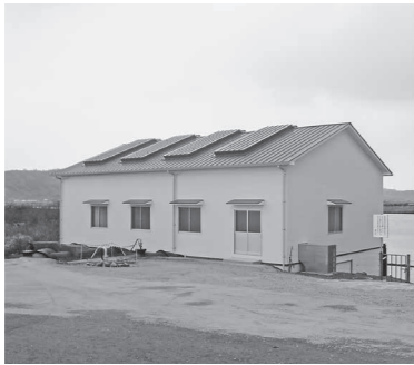
整備された排水ポンプ場
