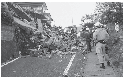
倒壊した建物を検索する救助隊員
